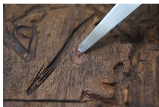
圖 53. 使用抹刀將填料刮勻
