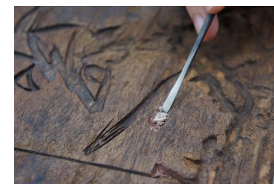
圖 54. 蓋上流動性較低的木材填料 Woody Paste
