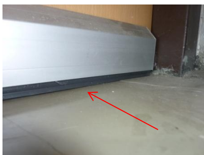
圖 15. 門關上後橡膠片自動下降
